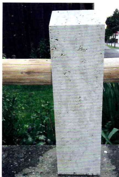
Pfeiler aus AUERKALKSTEIN mit Algen und Flechten nach der Reinigung
