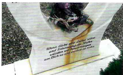
Rostschlieren, verursacht durch Bindedraht Fotos: Stefan Jedersberger
