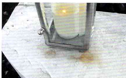
Verfleckungsursache waren hier die aggressiven Dämpfe der Ölkompilichte.
