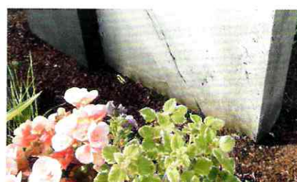
Verunreinigung durch Holz-Hackschnitzel Foto: Destag
